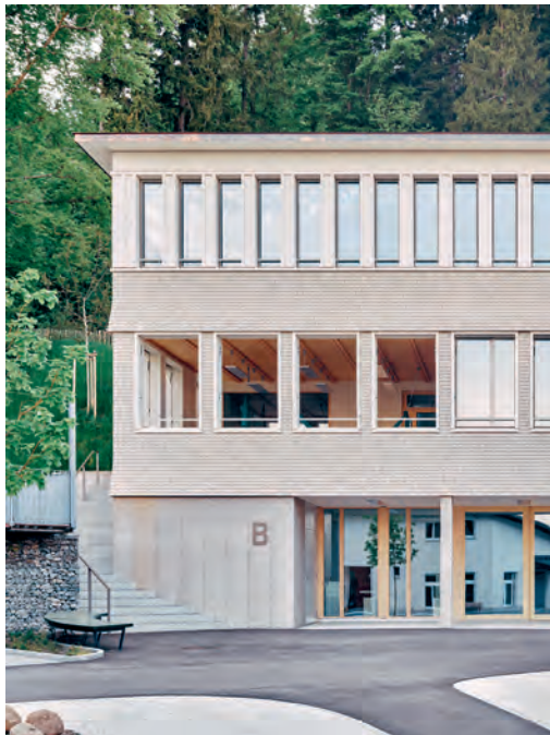
An der Fassade wechseln sich weiss lasierte Schindeln und Fensterbänder ab.
