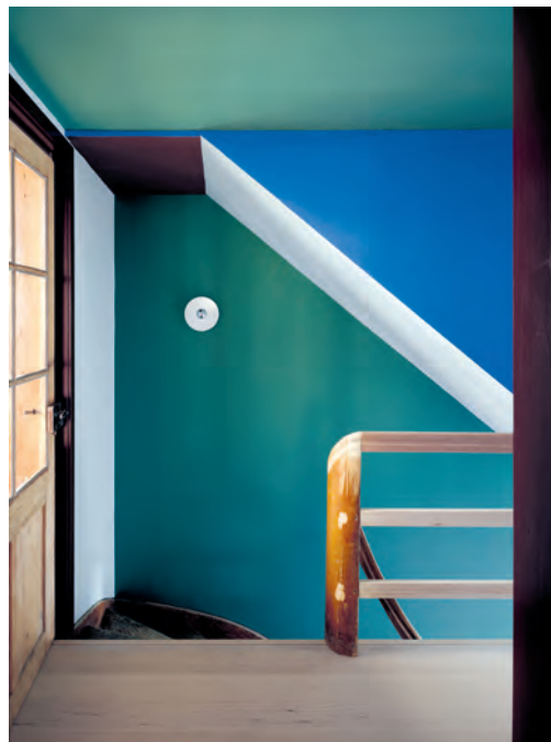
Das geflickte Geländer im farbigen Treppenhaus
