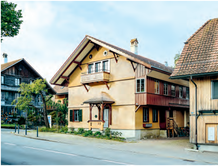
Von aussen ist die Sanierung beinahe unsichtbar.
